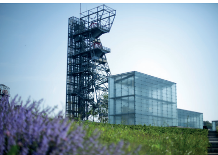
Szklane formy doświetlające
