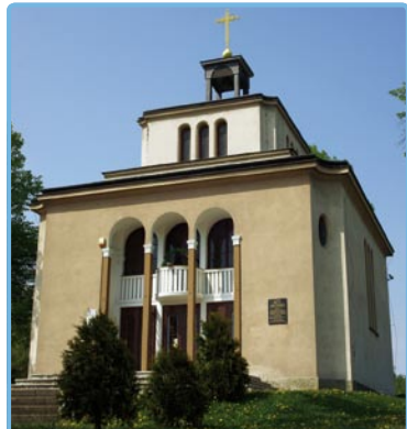
Kaplica na wzgórzu Kaplicówka, fot. D. Zaręba
