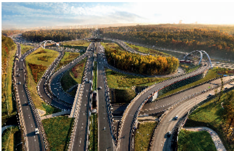
Węzeł Murkowska w Katowicach
