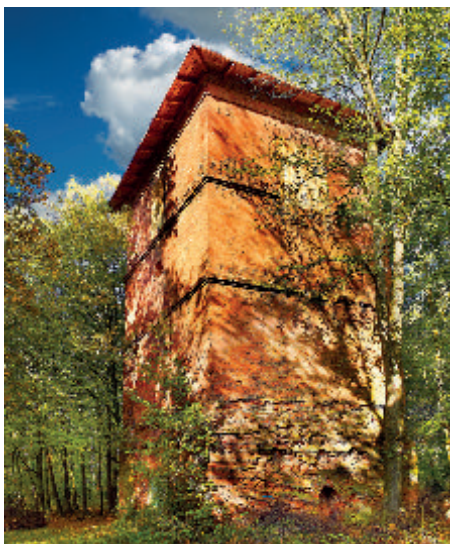
Zabytkowa gichta w Palowicach
